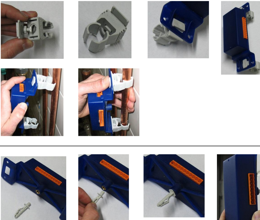
Afbeelding 4 Aansluitingen op de UCU (Temperature)
